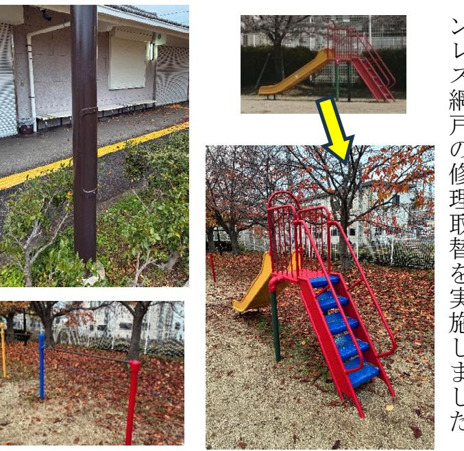
さくら公園の遊具と時計塔、照明柱の塗装が劣化したため、防錆塗装及び塗替えを行いました。また公園トイレのステンレス網戸の修理取替を実施しました。
