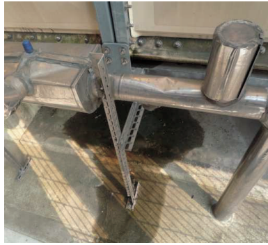
水漏れしている受水槽
