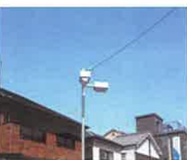
新しく設置された街路灯
